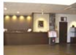
ロビーLED照明器具導入
