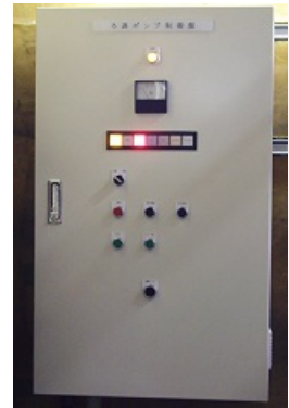
ろ過ポンプ制御盤
