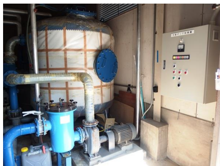
(有)伊万里スイミングろ過ポンプ省エネ 制御盤取付工事 (ろ過ポンプ省エネ制御盤「イケコン」) (自社商品)
