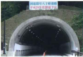
福岡322号八丁峠トンネル 消火設備設置工事
