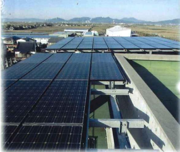
佐賀県は8月末の豪雨により各地で大きな被害が発生しました。全国的にも毎年災害による被害が増加している傾向です。弊社では、《省エネ》《創エネ》《防災》の目的で10kwの太陽光発電と5kwhの蓄電池の設置し、自然エネルギーを有効活用することで買う電気を減らしています。また、災害等で停電した場合には、太陽光で発電した電気を蓄電池に蓄えながら電気を使用できる環境を整えております。これにより停電時でも太陽光で発電した電気を蓄電池へ蓄えながら電気を使用できるので、日中は蓄電システムの
