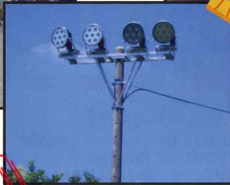
西武台高校サッカー場 ナイター設備LED化工事
