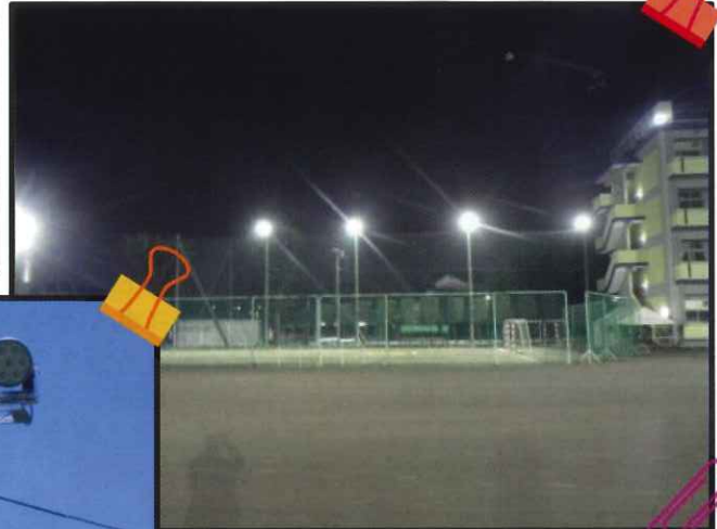
西武台高校野球場 ナイター設備LED化工事
