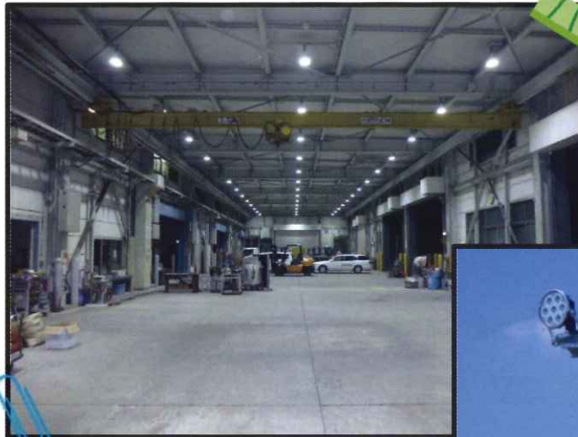
某航空会社倉庫 LED化工事
