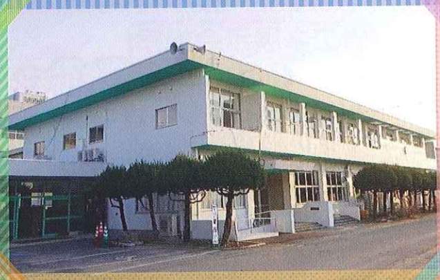
鳥栖市 鳥栖西中学校管理棟大規模改造工事
