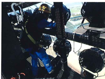
⑤高所での作業。1塔につき照明器具は84個あります。
