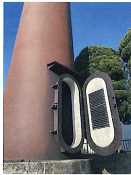
②照明塔の下に入口があります。
