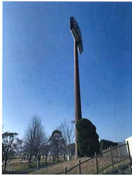
①高さ46m上での照明更新工事です。
